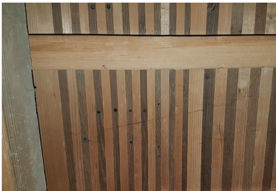
Spodná strana vzdušnice Hlavného stroja s „odfukmi“. Tie boli nutné pre netesnosť ventilov, ktoré sú bez lešenia neprístupné.
