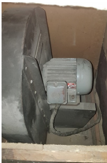
Nevyhovujúce hlučné čerpadlo vzduchu.
